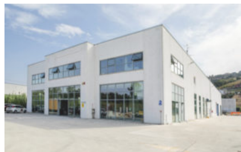
Stabilimento di Colonnella (TE)
